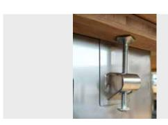
Die Spüle soll mit dem Rand UNTER der Arbeitsplatte montiert werden (Undermount).
