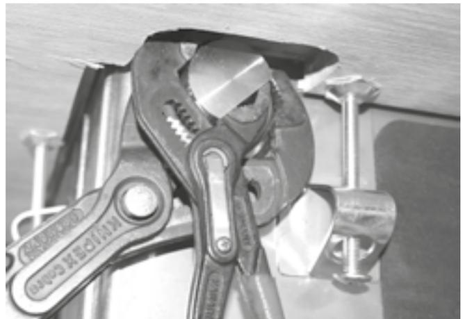
**⚠ ACHTUNG:** Die 2. Zange bitte unbedingt so ansetzen dass die Gewindeeingänge nicht beschädigt werden, sonst hast du nachher Schwierigkeiten die Flexschläuche zu montieren und dicht zu bekommen! Anschließend die zwei Flexschläuche vorsichtig in die Armatur eindrehen und nur mit der Hand anziehen, nicht mit einer Zange! Achte auf richtigen Sitz der O-Ringe. Warm- und Kaltwasser sind mit farbigen Punkten gekennzeichnet.
